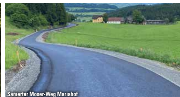
Sanierter Moser-Weg Mariahof
