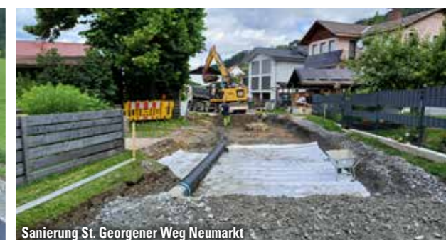
Sanierung St. Georgener Weg Neumarkt
