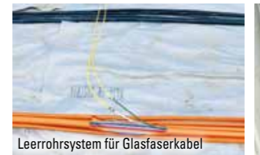
Leerrohrsystem für Glasfaserkabel
