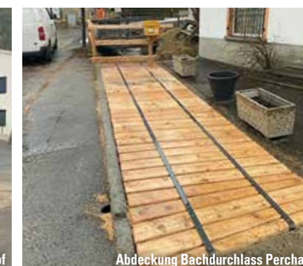
Abdeckung Bachdurchlass Perchau
