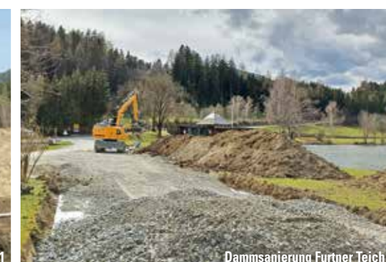
Dammsanierung Furtner Teich 2
