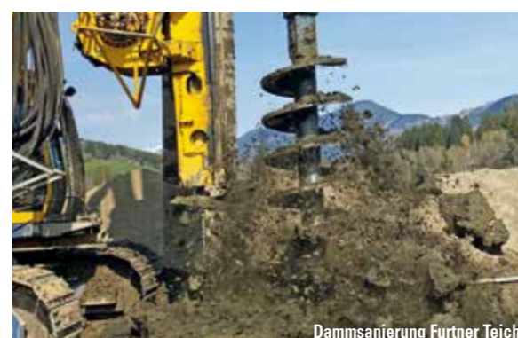
Dammsanierung Furtner Teich 1
