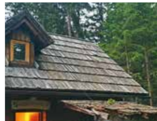
Das Vereinsheim vor und nach der Dacherneuerung.
