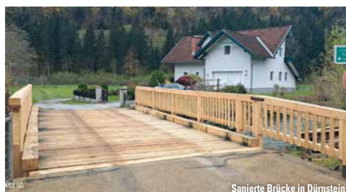
Sanierte Brücke in Dürnstein
